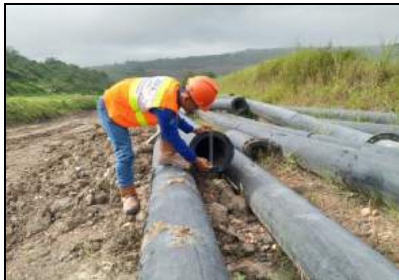
Gambar 4.6 Pipa HDPE yang digunakan pada PT. Bukit Makmur Mandiri Utama
